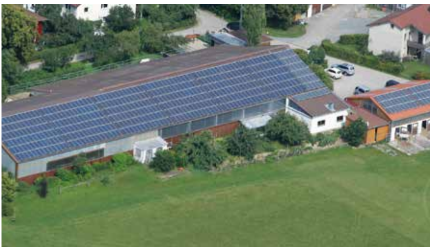
Gäufelden-Nebringen - Deutschland Anlage: 31,85 kW | SpeedRail
